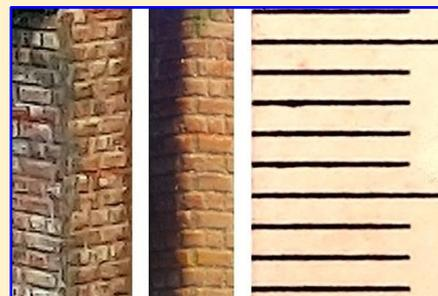
Links Folie an der Gebäudekante gestossen, rechts Folie um die Gebäudekante herumgeführt
