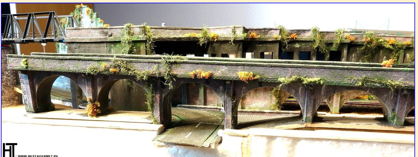
Einbausituation im Rohbau einer anderen Rampe im selben Bausystem mit komplett offenen Arkadenbögen
